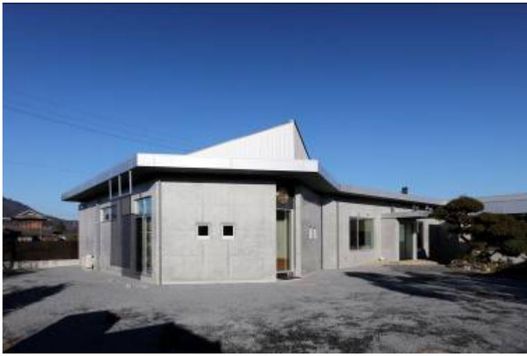
硬質発泡ウレタンで屋根、壁、床下を全て覆い尽くしてある、又一種換気の熱交換器による温度管理された空気を床下に送り天井から排気する空気循環により床下からの冷え込みを和らげる仕掛けも組み込んだ、もちろんお寺という性格上一日中エアコンを掛け空気循環を廻す機会はあまり無いのだが行事事など人々が多く集まる時には効果を発揮してくれると思っている。
