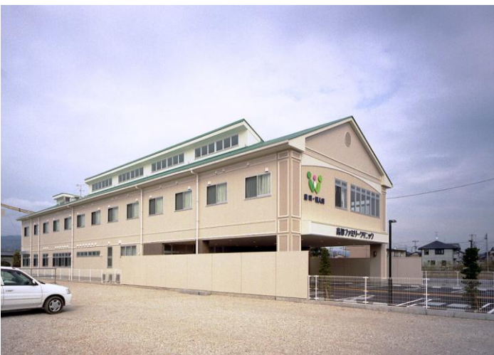
施工したクリニックの例
