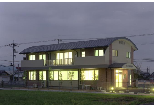
施工したクリニックの例
