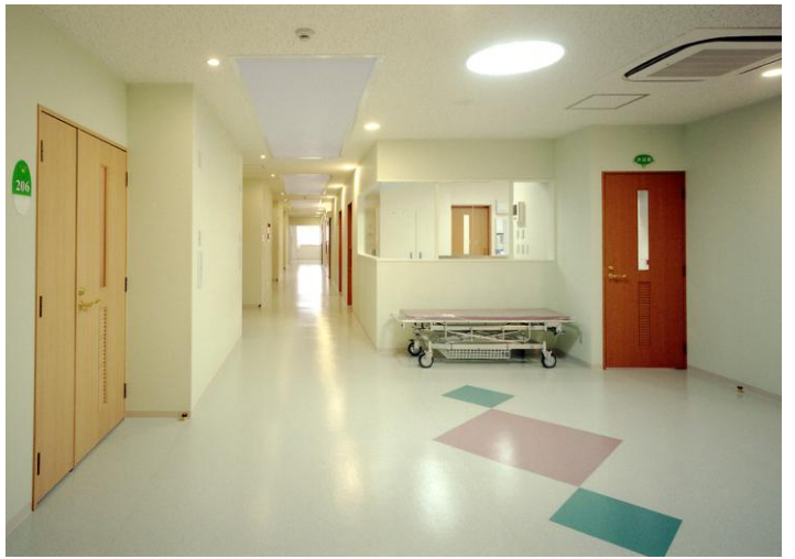
施工したクリニックの例
